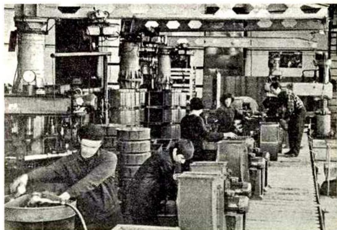
Механосборочный цех 18, сборка вентиляторов на конвейере
